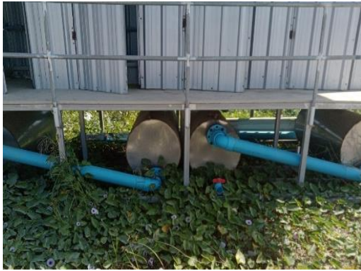
รูปที่ 18 ถังบำบัดน้ำเสียสำเร็จรูป
