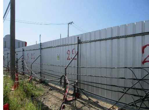
รูปที่ 2 ติดตั้ง Metal Sheet เป็นรั้วชั่วคราว
